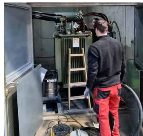
ENVESTA-Mitarbeiter bei Servicearbeiten an spannungslosen Anlagenteilen
