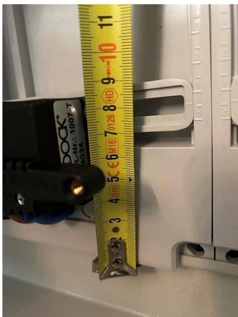
Abbildung 8: Schienenabstand für die Montage der Zähleranschlussklemmen
