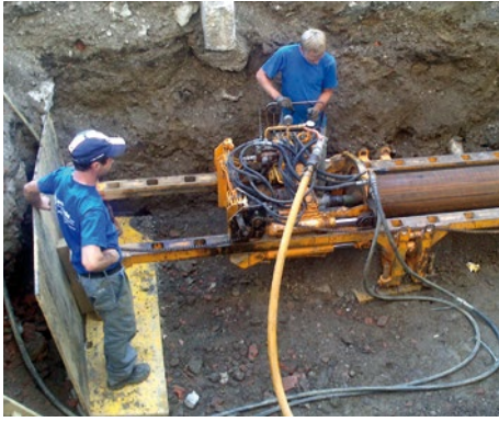
2013 Durchbohrung unter dem Verbindungs-gang Stiftsgymnasium Admont
