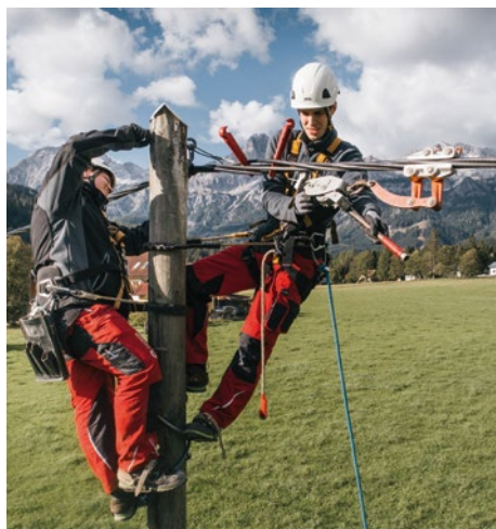
Keine Verschnaufpause: Im Sommer steht die Umrüstung von Freileitungen an
