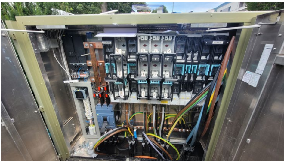
Umbau einer Trafostation für die Einbindung einer PV-Anlage in das Versorgungsnetz
