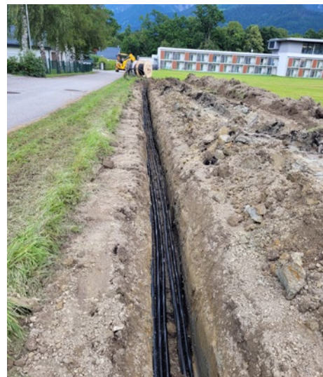
Verlegung der Energieableitung für eine PV-Anlage
